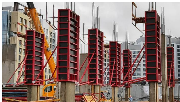
Рис. 1. Опалубка при монолитном строительстве
